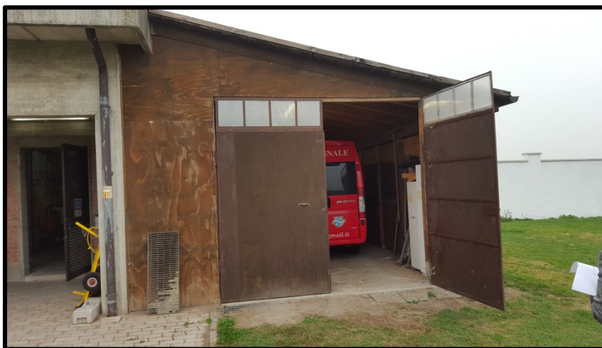
Struttura in legno da demolire
